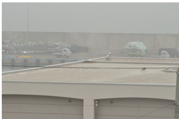
図 7. 屋根付き岸壁での営巣状況(写真は苫前港での例)
