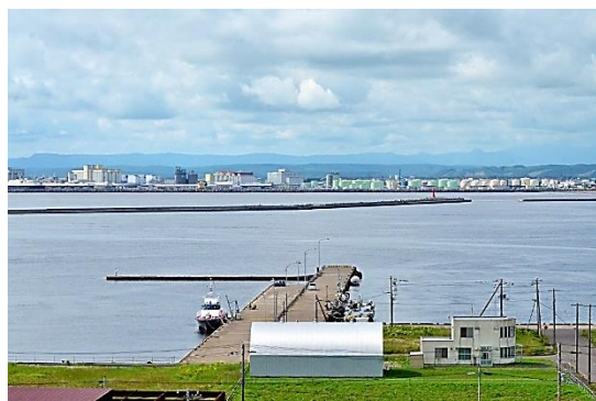
260 巣の営巣が確認された離岸堤 2016年8月2日撮影
