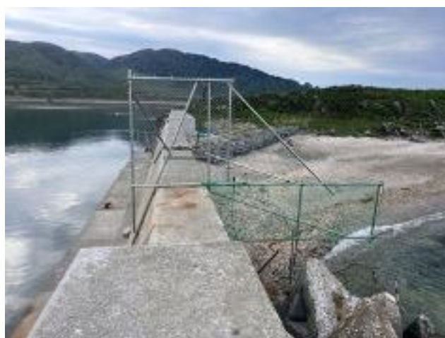
図2 2022年に補修された哺乳類防除フェンス。画像奥にウミネココロニーが続く。
